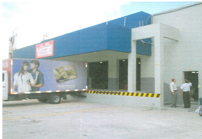
FACHADA TRAV. S. FRANCISCO
